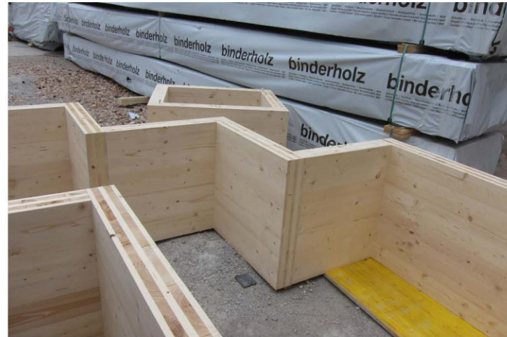
...begleitet von den skeptischen Blicken der Betonbauer die ersten Brettsperrholzwände sind rasch versetzt...
