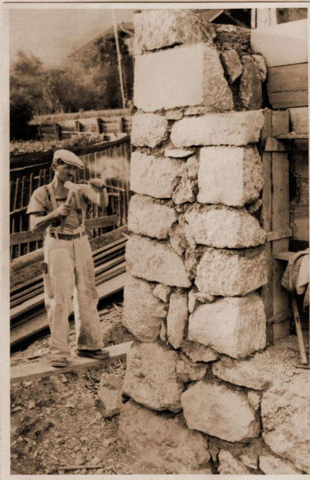
Der spröde, schwer zu arbeitende Kalk- stein des Ennstales musste für den "Sockelbau" verwendet werden.
