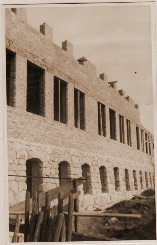
Die entsprechend der Rundung des Han- ges gebogen verlaufene Mauer wächst.
