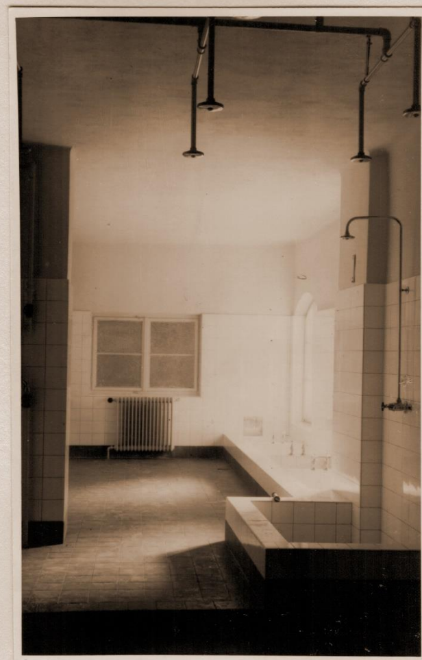
Der zugehörige Wasorraum mit „Wasserbrausen, Waschrinne und Fußwaschbecken“.
