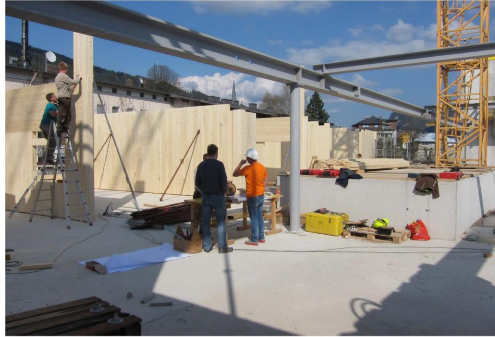
...begleitet von den skeptischen Blicken der Betonbauer die ersten Brettsperrholzwände sind rasch versetzt...
