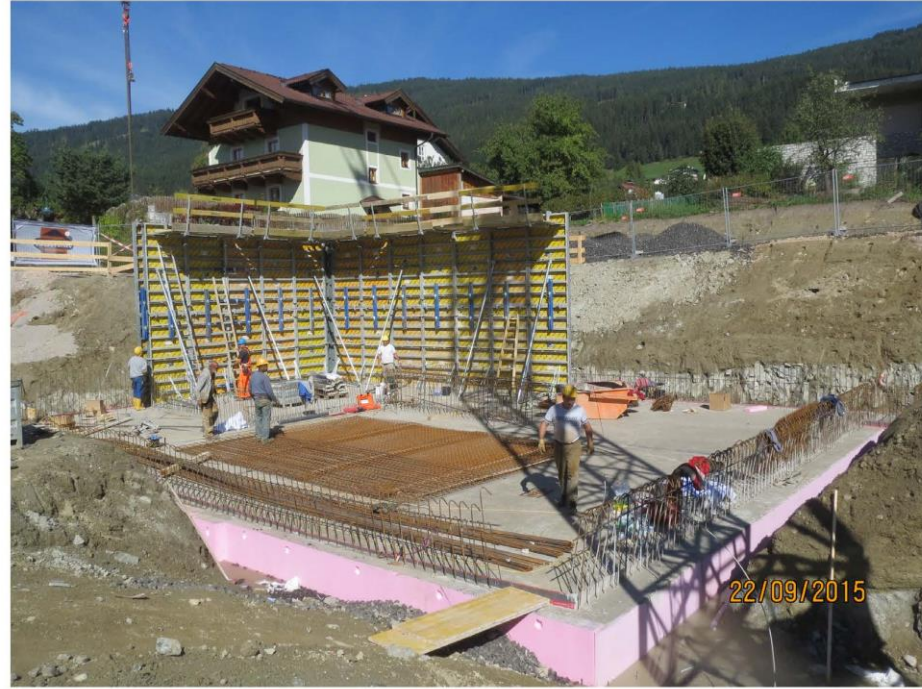
Liftschacht und zwei Untergeschoße samt Kollektorgang entstehen bis Mitte Jänner 2016
