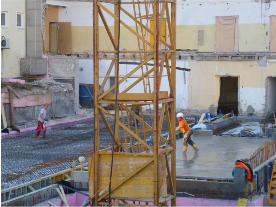
die Schule wird um den Kran herum gebaut...
